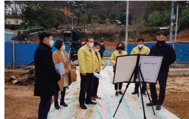
오륜동 주차장 건설 공사 현장 방문
