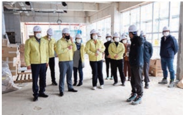
금샘도서관 공사 현장 방문
